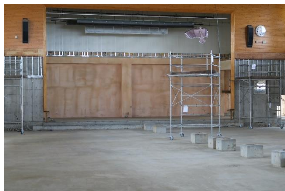
(体育館洗浄後の様子)
