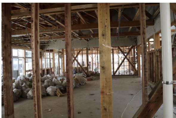
(実習棟解体の様子)
