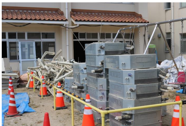
(取り外された天井の空調機など)
