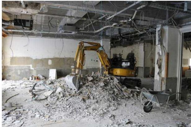
校舎の1階です。重機が校舎内に入り、天井、壁、床などは全てはがされて、廃棄物が外に運び出されています。
