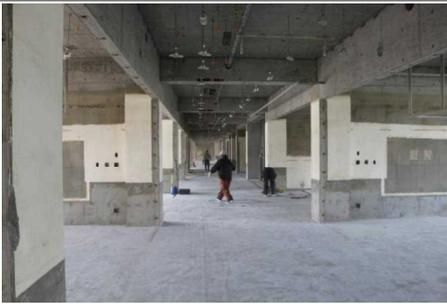
校舎の1階です。壁や床等が運び出された後、床のタイルや壁材などをつけていた接着剤をはがしています。この後、清掃、洗浄をした後乾燥させる予定です。
