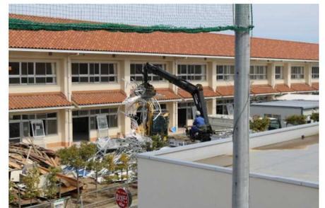
トラックで廃棄物を運び出し、校舎前に運び出された廃棄物はクレーンを使って積み出しています。
