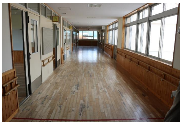
(2階廊下の様子)
